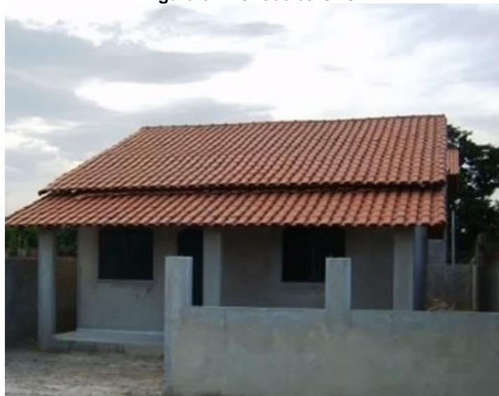
Figura 3 – Telhado da CASA
